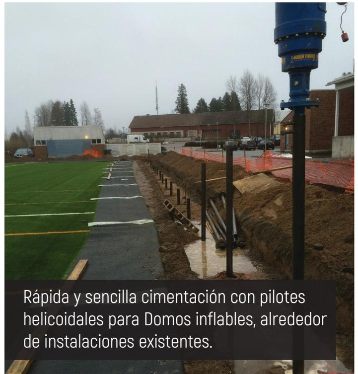
Rápida y sencilla cimentación con pilotes helicoidales para Domos inflables, alrededor de instalaciones existentes.
